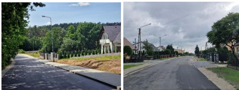
Fot. Droga w Obkasie i ul. Leśna w Dąbrówce po przebudowie, UM w Kamieniu Krajeńskim
