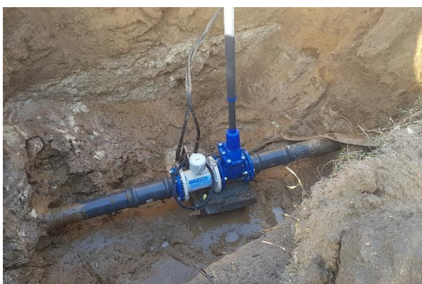
Fot. Montaż przepływomierzy i rejestratorów przepływu i ciśnienia na sieci wodociągowej - strefowego opomiarowania w ramach efektywnego monitoringu
