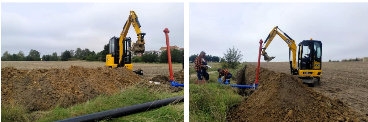
Fot. Budowa sieci wodociągowej w ul. Makowej w Kamieniu Krajeńskim
