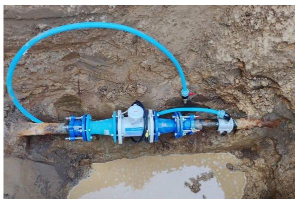
Fot. Montaż przepływomierzy i rejestratorów przepływu i ciśnienia na sieci wodociągowej - strefowego opomiarowania w ramach efektywnego monitoringu
