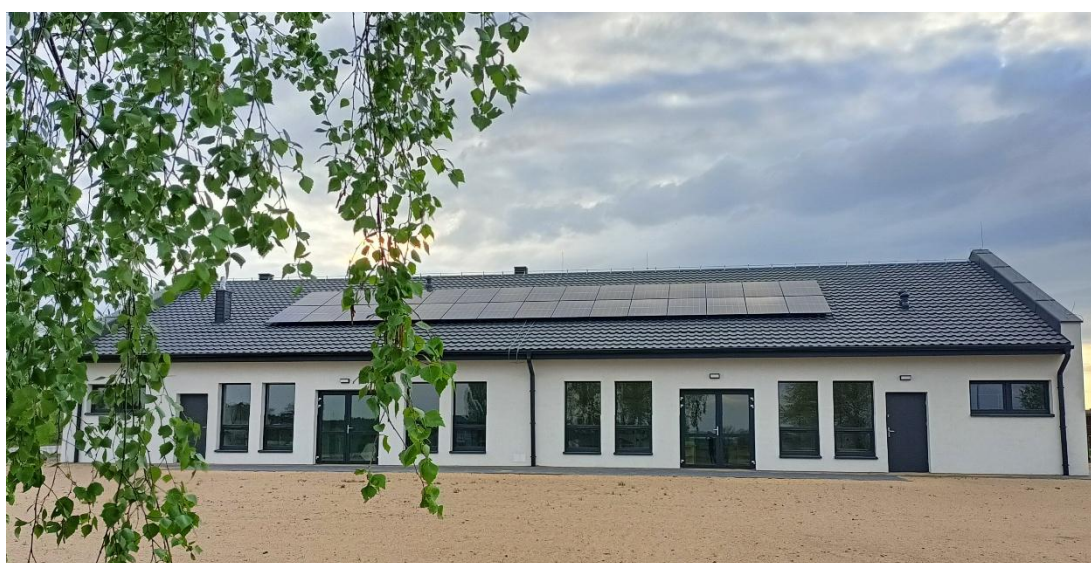
Fot. Budynek żłobka w Kamieniu Krajeńskim
